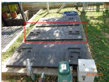
ภาพที่ 2-31 บ่อพักน้ำทิ้งสุดท้าย (Holding Pond)
