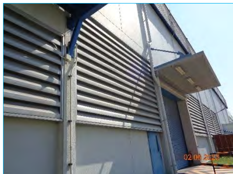
ภาพที่ 2-2 ระบบระบายอากาศในอาคาร บริเวณที่มีความร้อนสูง
